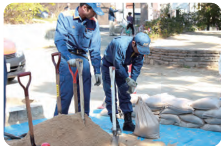
土のうはしばった口を下に、積み方も工夫して
